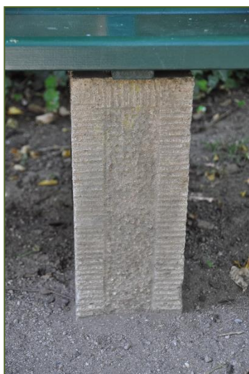
Abb. 11 Bankfuß mit charakteristischer Scharrierung
