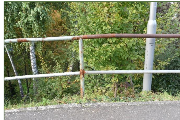
Verrostetes und gestalterisch unpassendes Geländer an der Rampenauffahrt zur Fußgängerbrücke über die Bahnlinie
