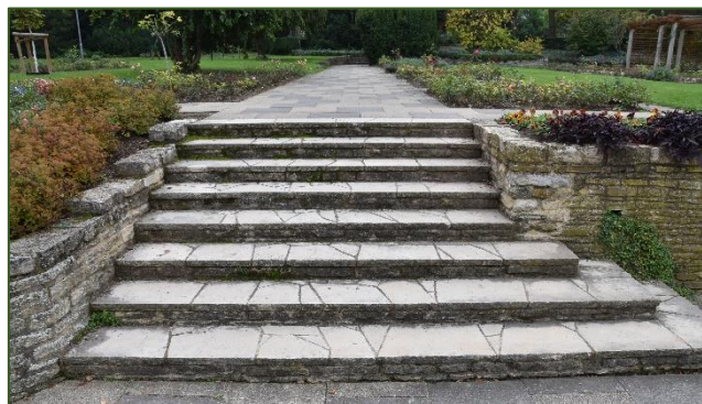
Sanierte Mauern und Treppenanlage im Rosengarten
