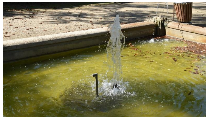
Riesenkopfbecken im Rosengarten mit neuer Fontänen-Installation und niedrigem Wasserstand
