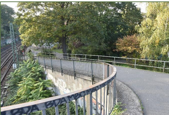
Verrostetes und gestalterisch unpassendes Geländer an der Rampenauffahrt zur Fußgängerbrücke über die Bahnlinie
