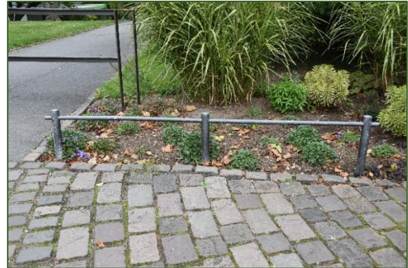
Verrostete „Fahrradschleuse“ und funktional fragwürdige Kniegitter am Parkeingang nahe dem Vogelhaus
