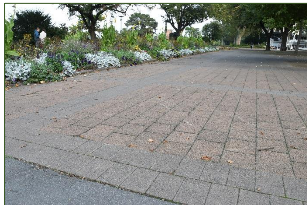
Zweifarbiges Betonpflaster auf der Rheinterrasse
