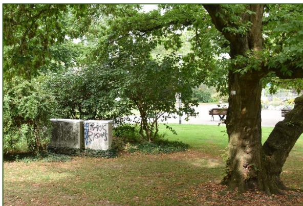
Schaltkasten südlich der Rheinterrasse
