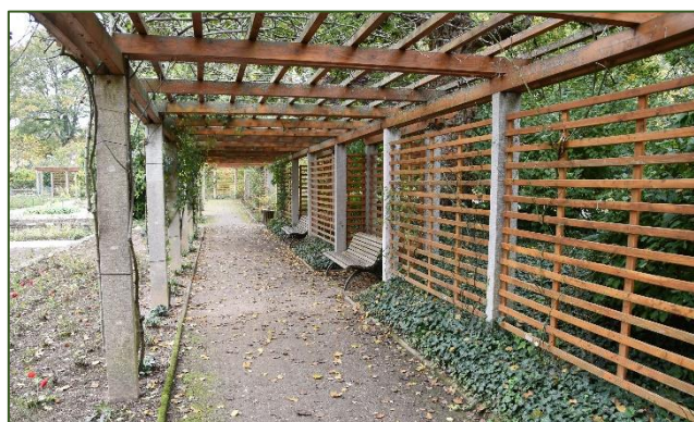
Sanierte Pergola an der Westseite des Rosengartens
